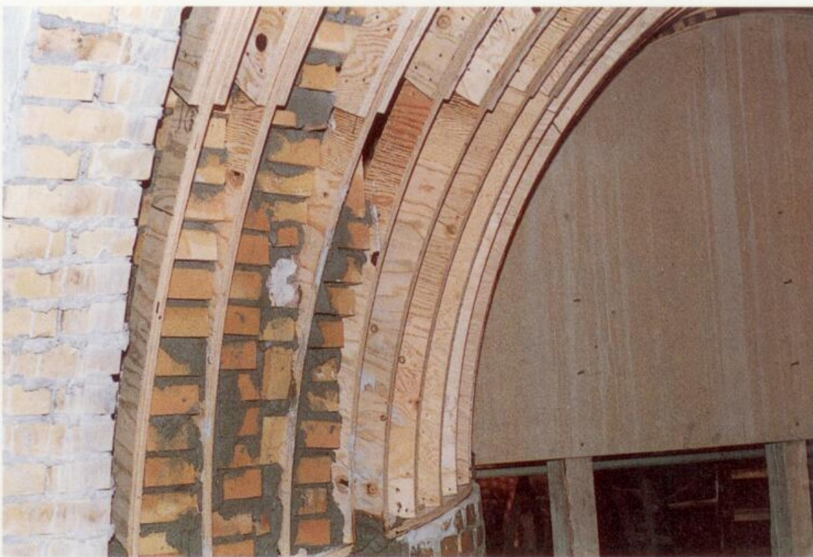
Skellet til buegang på DB Brugsen, Nørrevold mellem ny og gammel butik.
